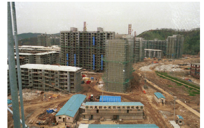
목동신시가지 공사현장 모습, 1985년
