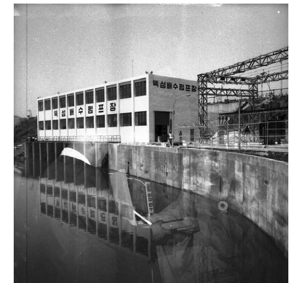
보광동.독섬.구의동 배수관 공사현장, 1969년
